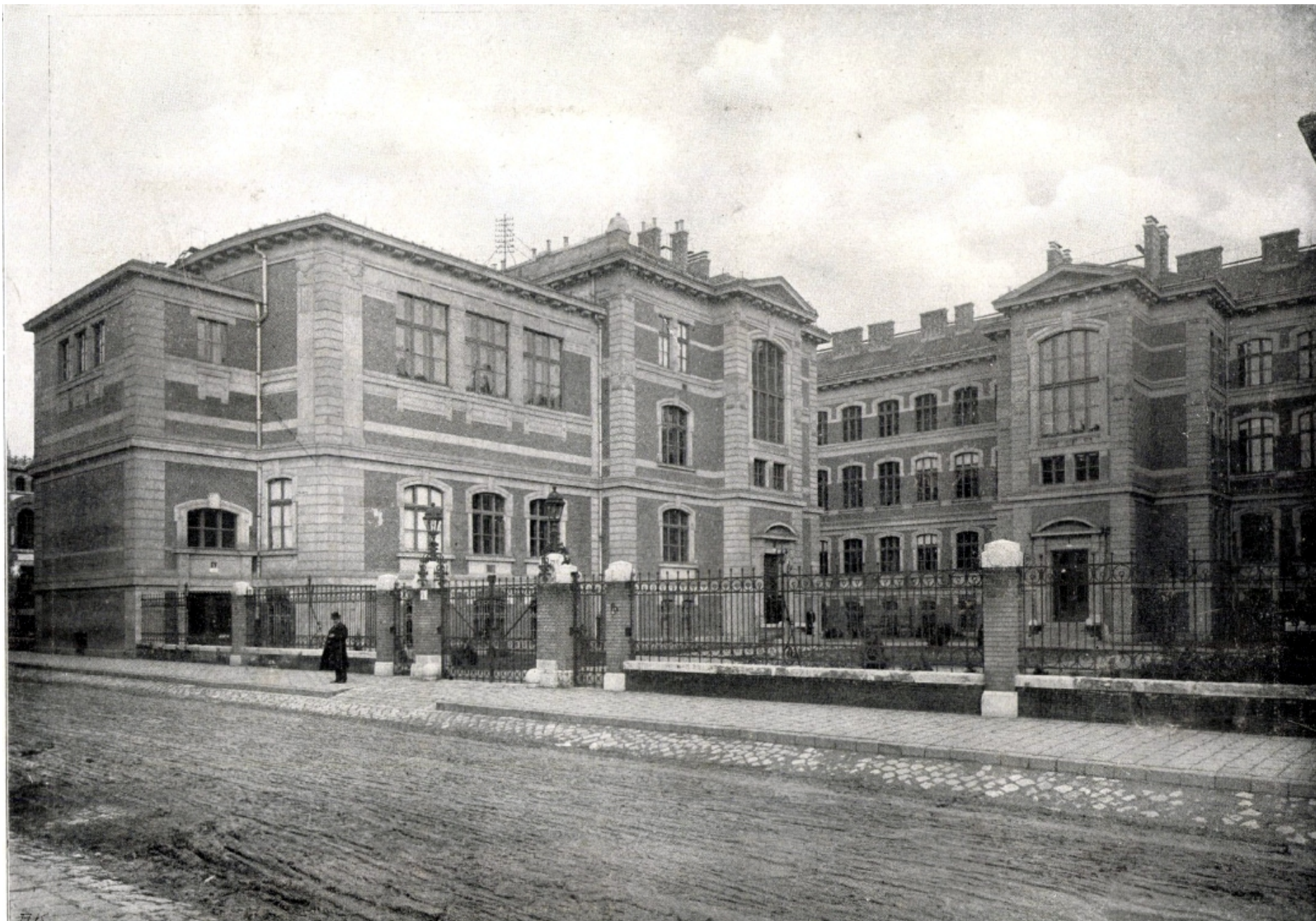
Az elektrotechnikai és fizikai intézet épületét 1906-ban adták át
