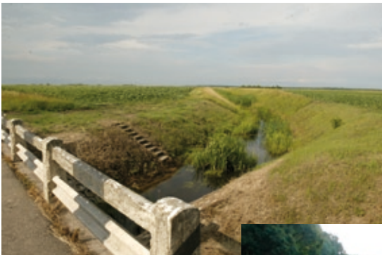
Belvízlevezető csatorna szabályos trapézmederrel, a partig érő felszántott területtel
