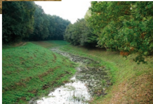
Parti pufferzóna és kanyargós meder kialakításával rehabilitált kisvízfolyás
