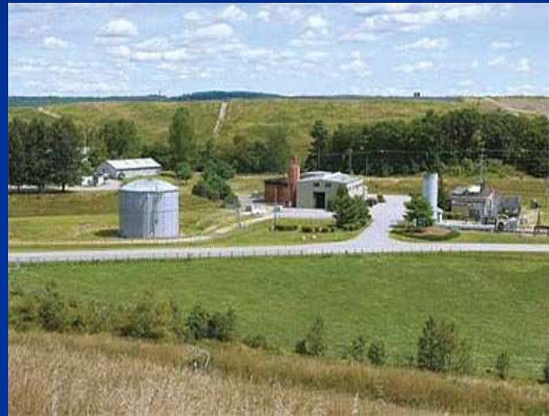
1. ábra: Depóniagáz telep
