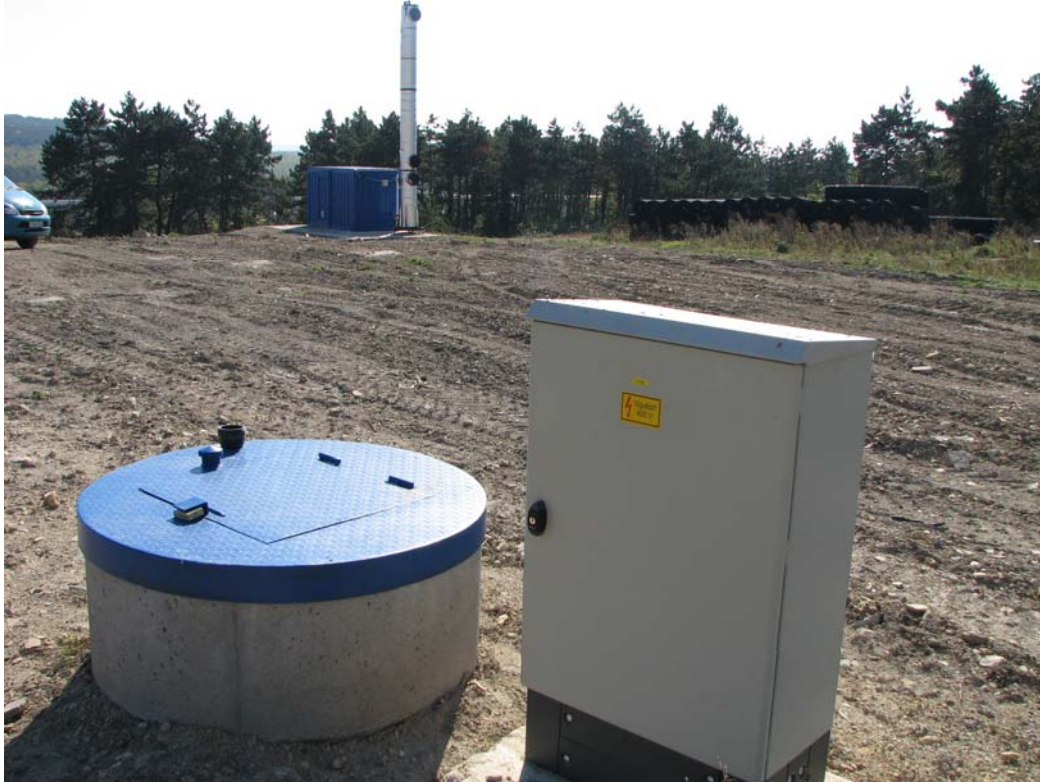
Termelőkút és vezérlőegység, háttérben mobil sztrippelő toronnyal
