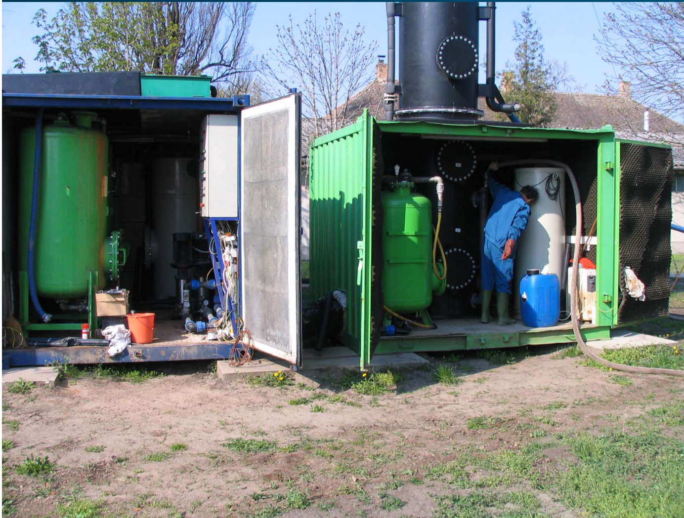
Mobil sztrippelő berendezés (Air stripping container)
