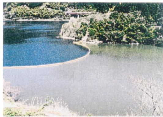
7. kép: A vízfűggöny alkalmazása a Terauchi Dam víztározónál (Asaeda et al. , 2001)
